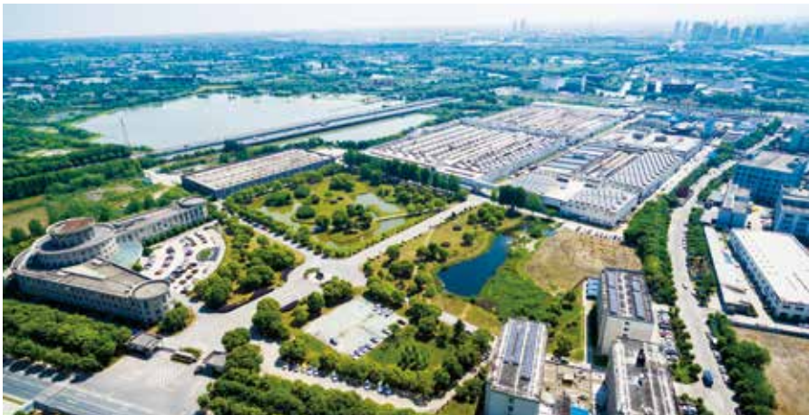
美欣达屋顶光伏发电项目场景。
